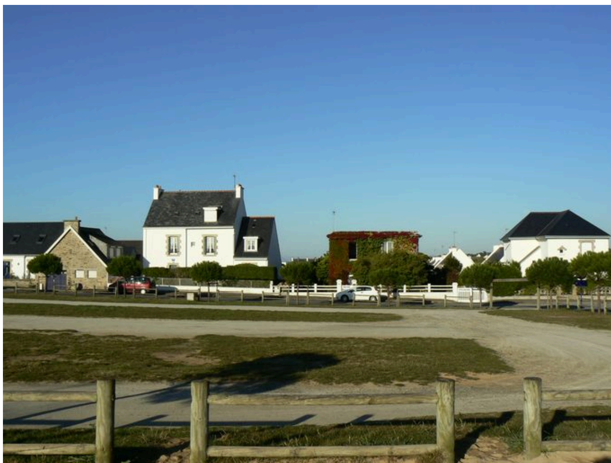
Vue générale des Villas Nestour
