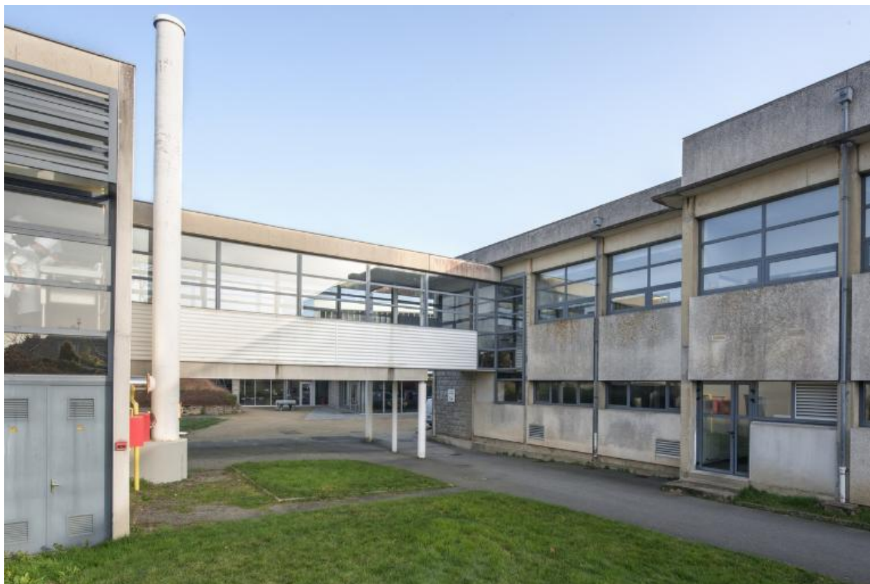
Passerelle entre le restaurant pédagogique et les ateliers.
