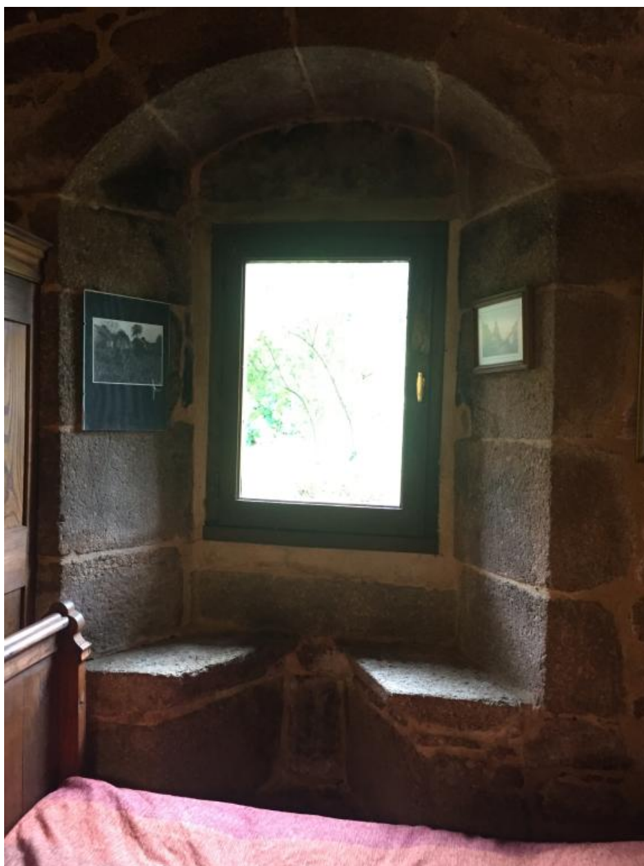
Fenêtre avec coussières
