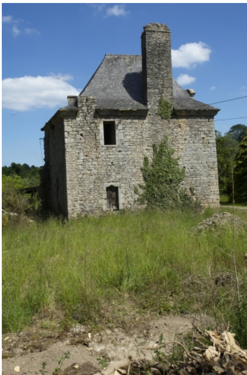
Elevation ouest du pavillon
