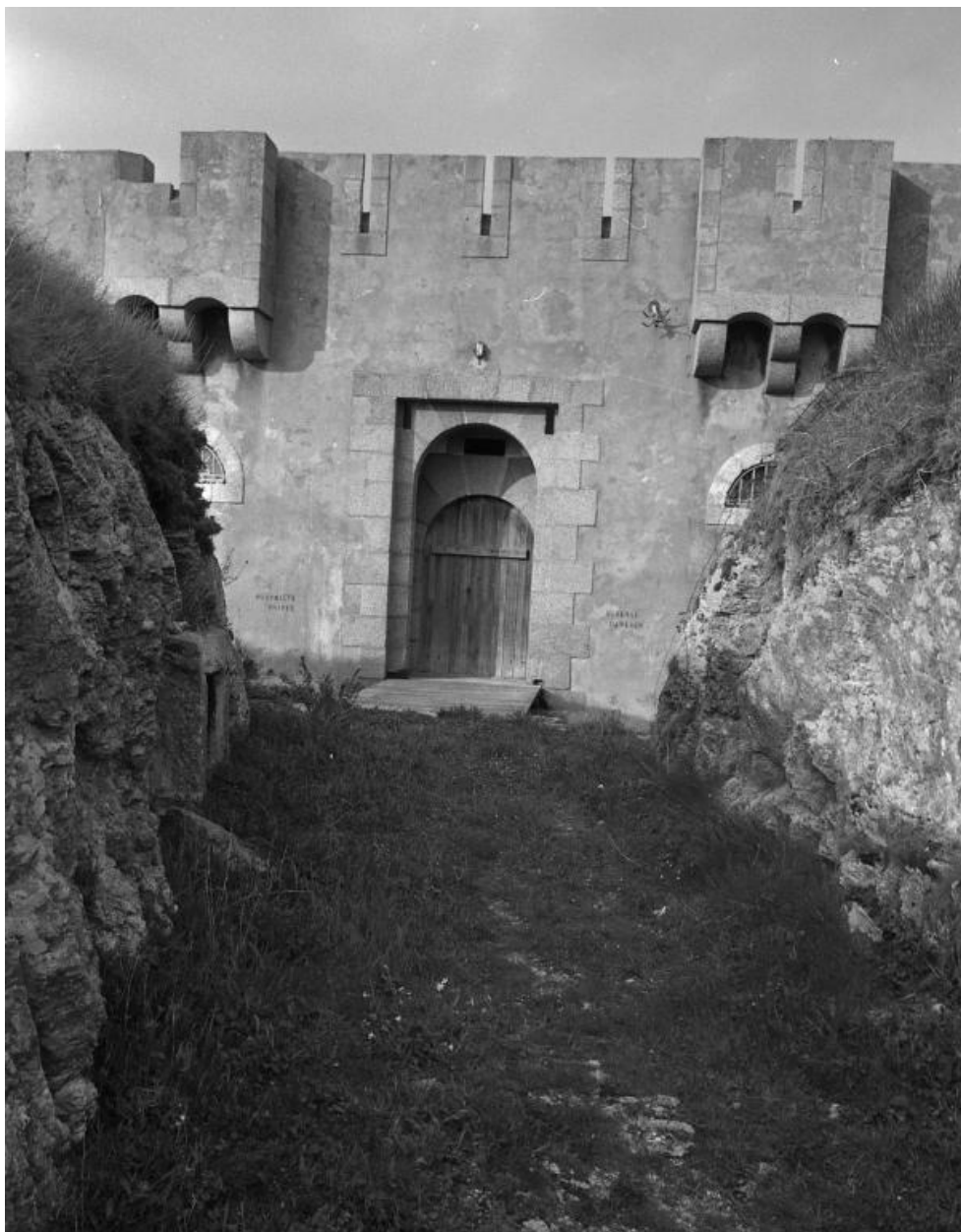
Locmaria, batterie de Kerdonis, corps de garde crénelé, état dans les années 1970.
