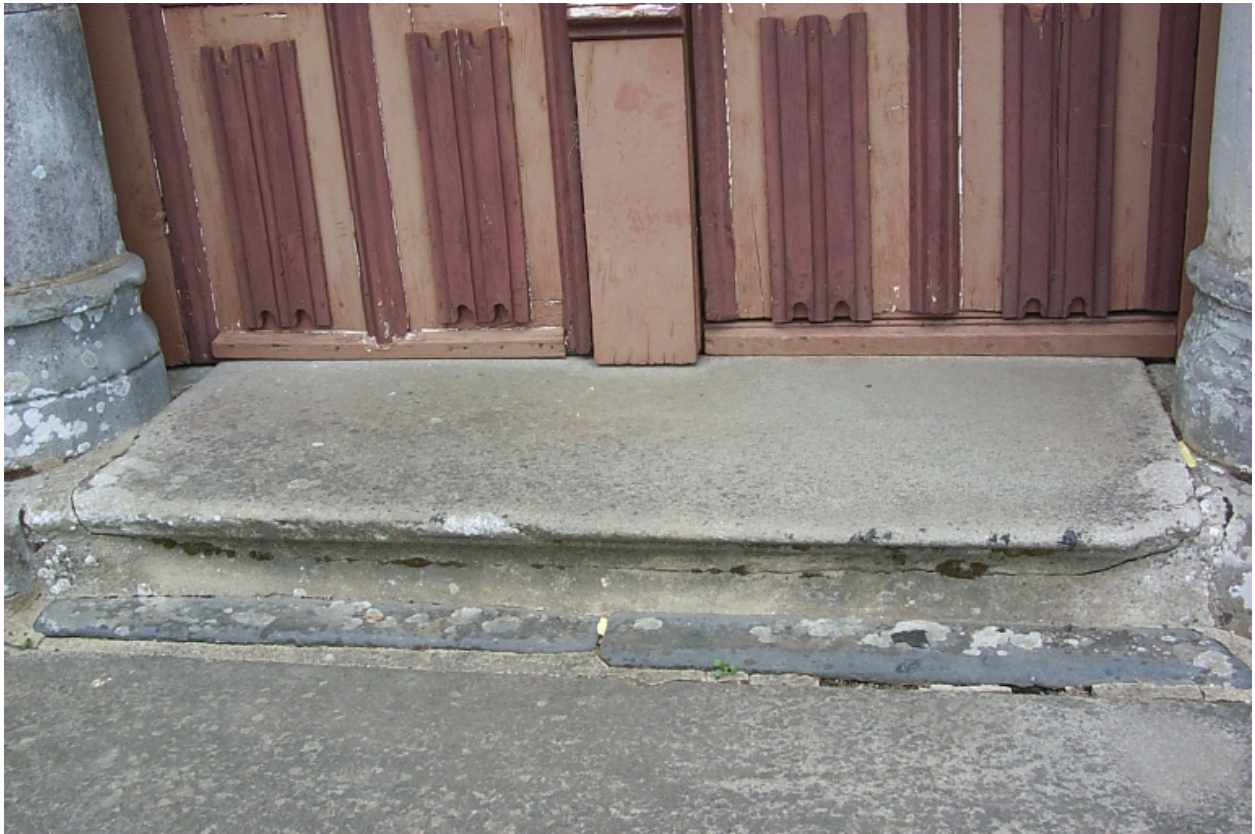
Porche occidental, ancien autel réemployée comme pierre de seuil : vue générale ouest
