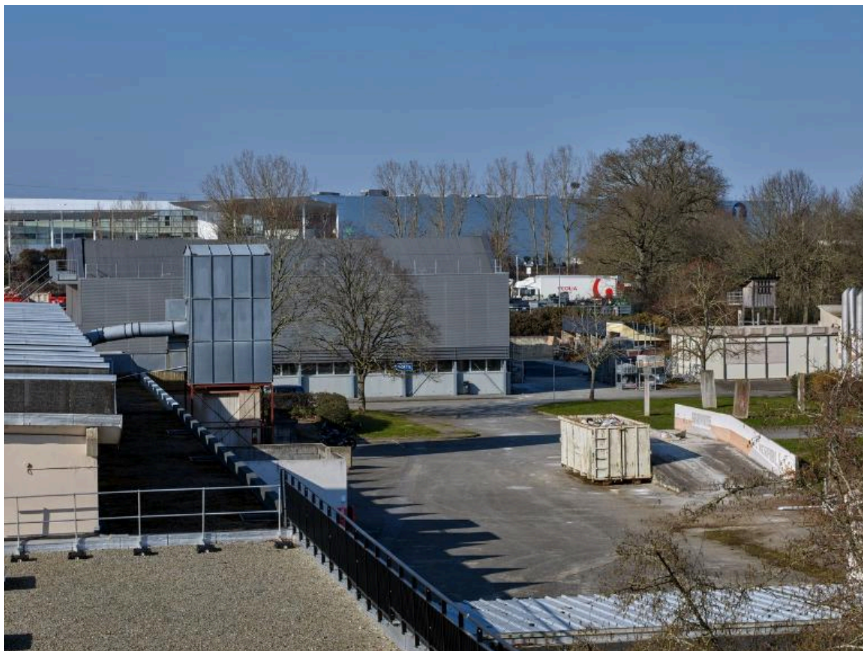
Façade sud des ateliers pédagogiques (bâtiment N), prise du toit des grands ateliers.
