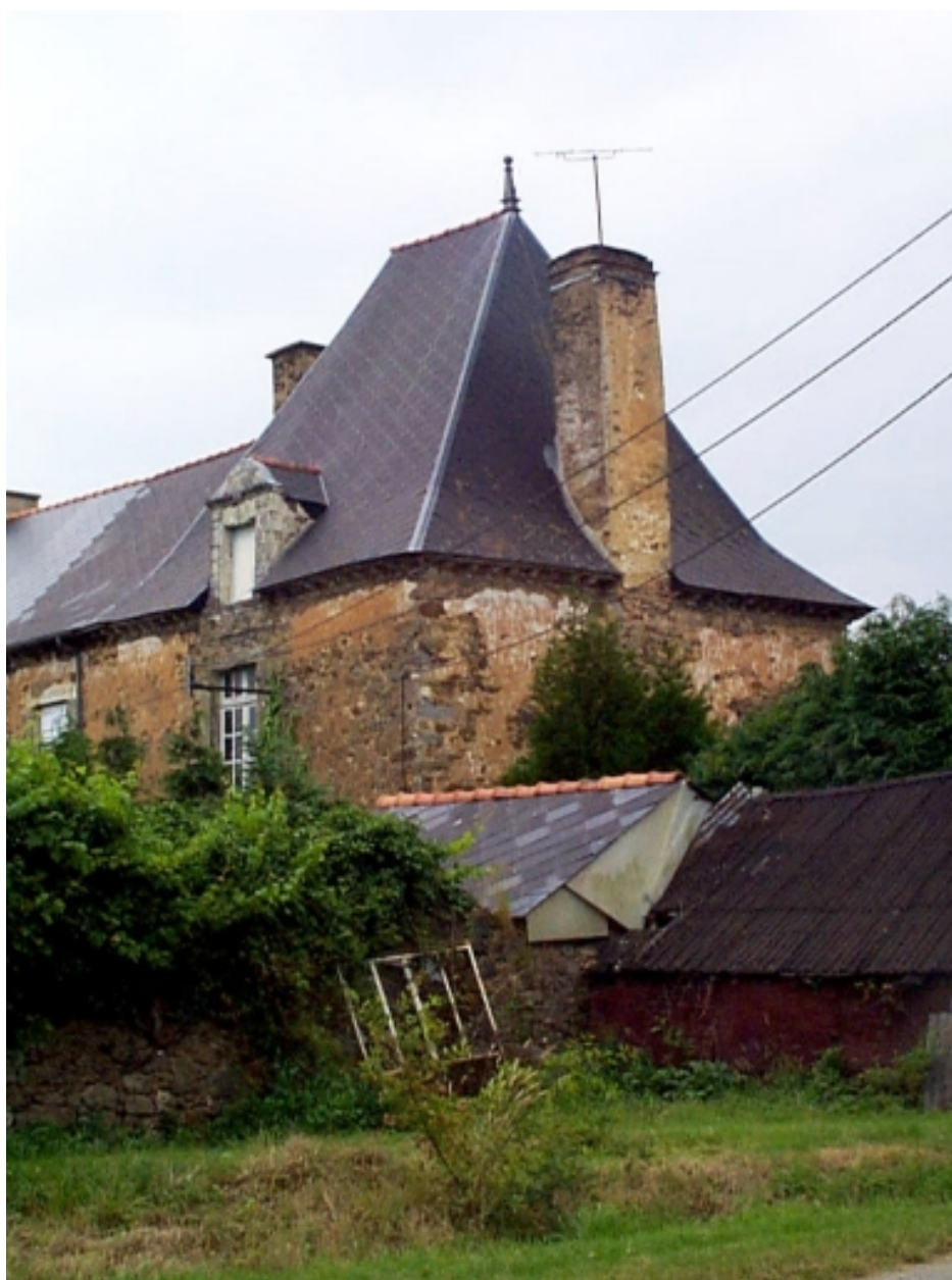
Vestiges du corps de logis, le pavillon : vu générale sud-est.
