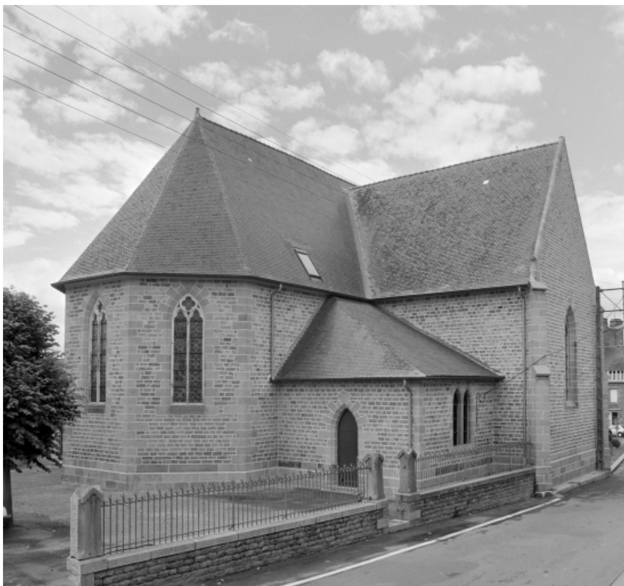
Elévation Nord-Est : vue générale
