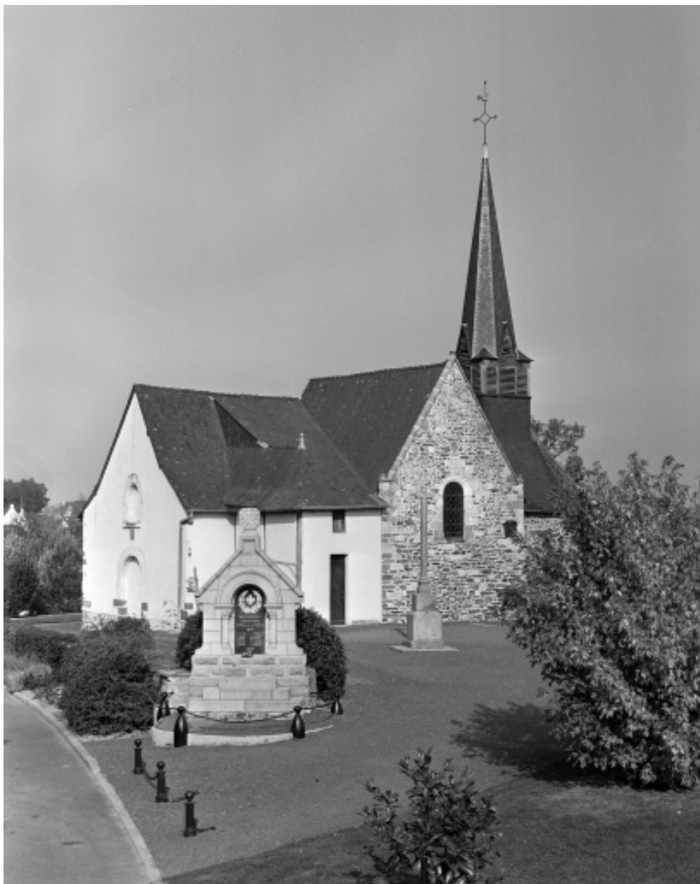
Elévation sud, état après restauration
