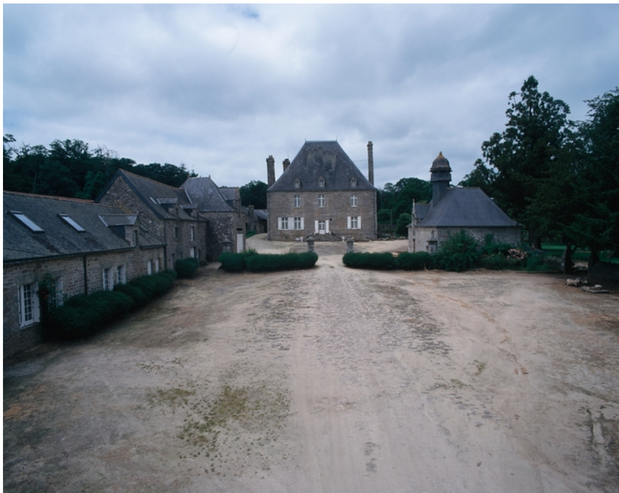
Vue générale sud.
