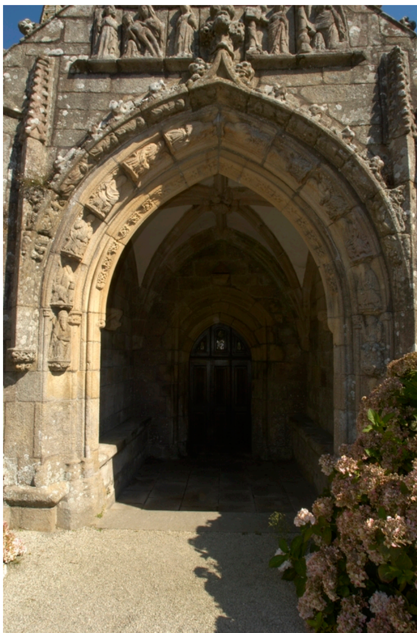
Porche sud, vue de l'arc d'entrée avec le collège des apôtres
