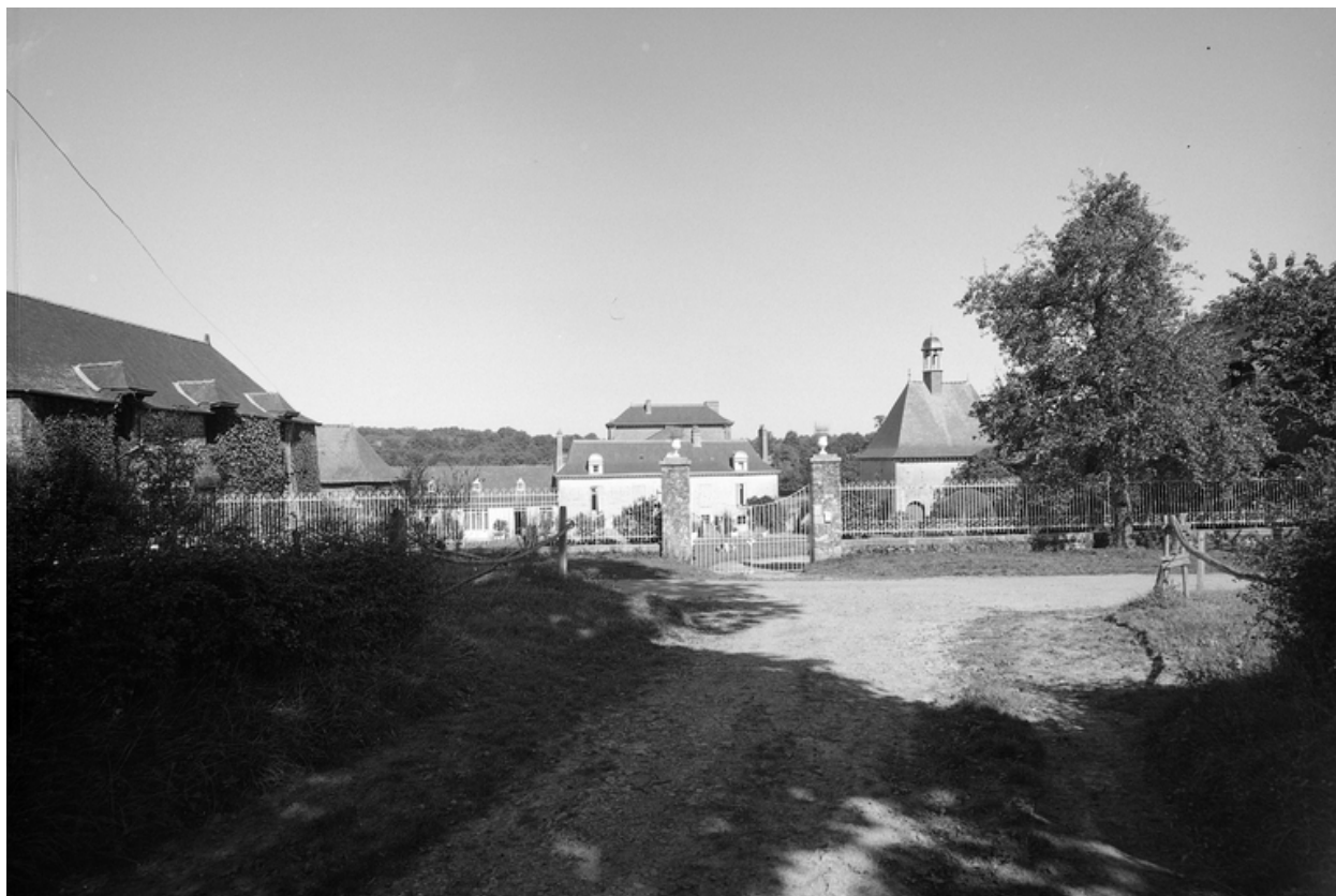
Vue de situation ouest.
