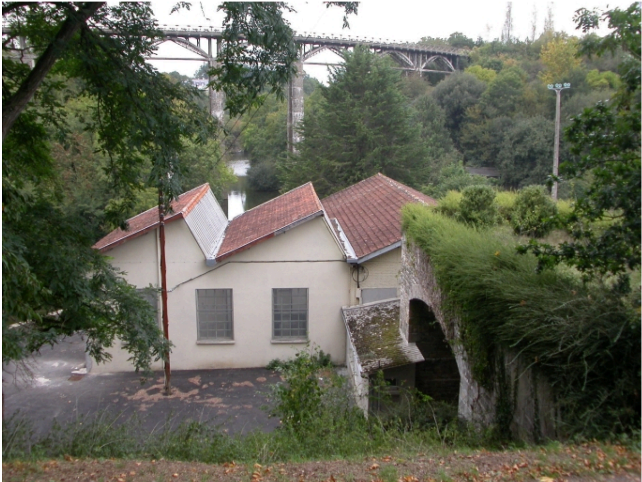
La "salle de relayage" et vestiges de l'ancienne centrale (à droite), vue sud.
