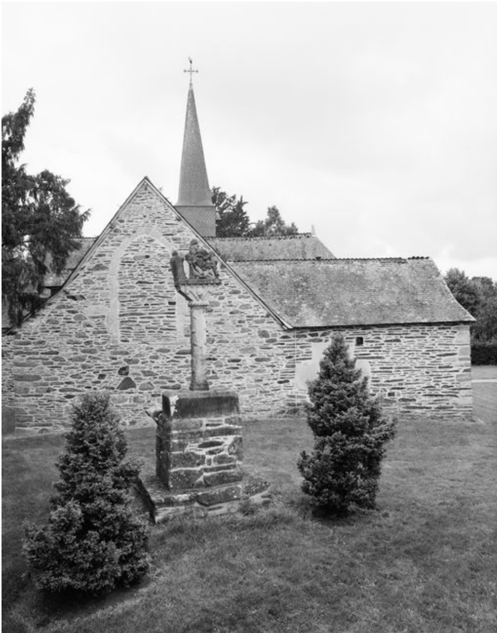
Vue générale prise de l'est
