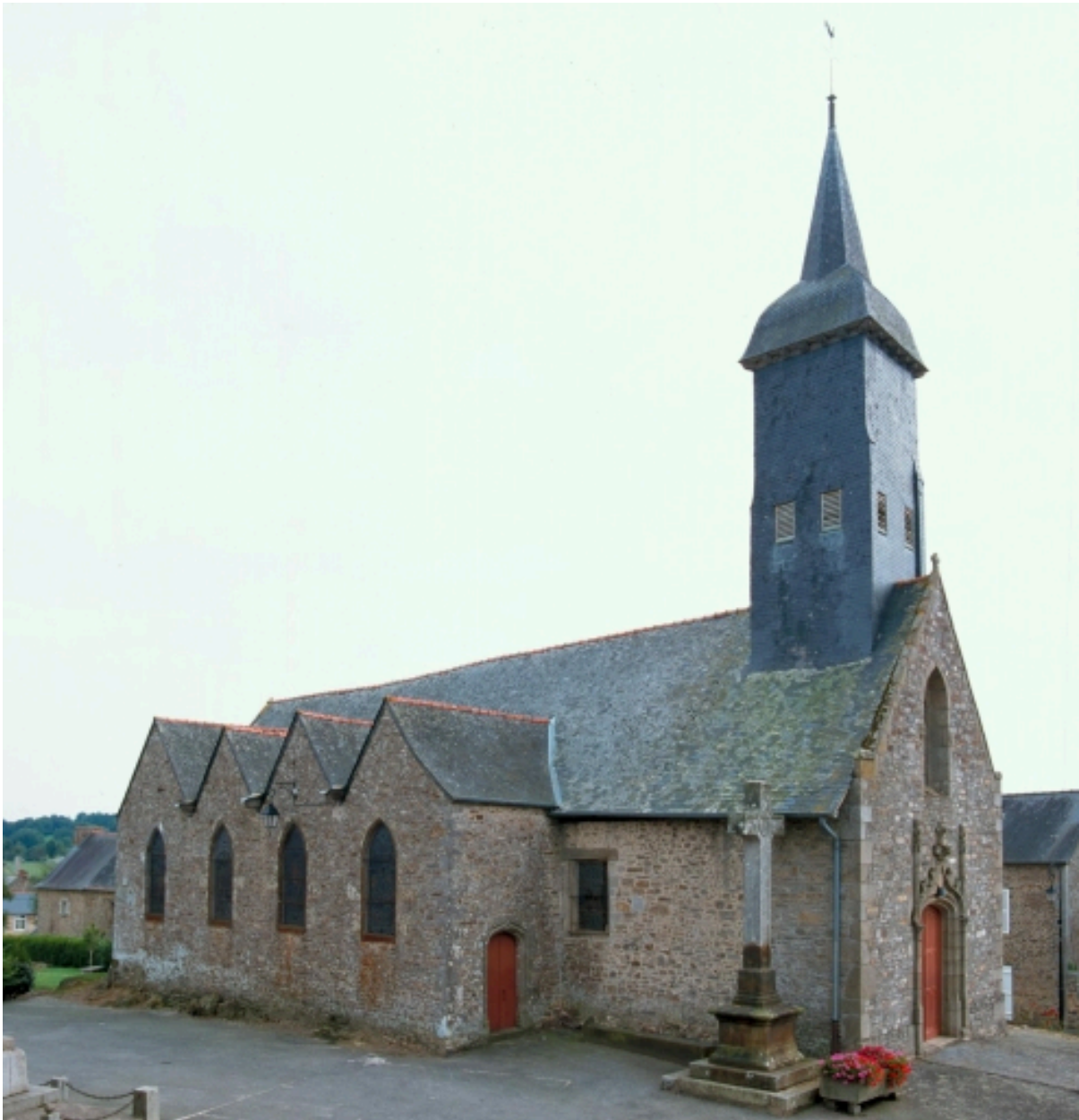
Vue générale nord
