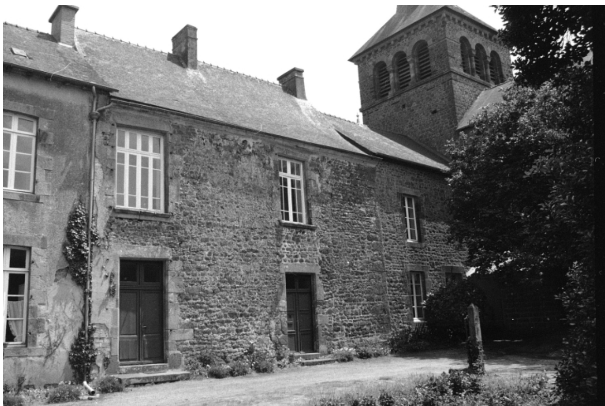
Façade ouest en 1975
