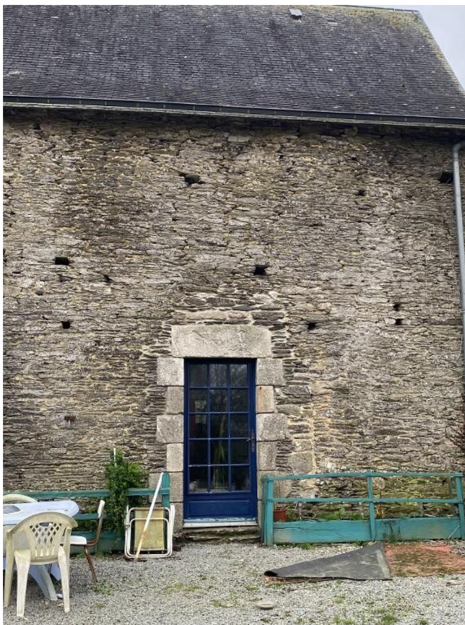
Aile nord, élévation nord, détail
