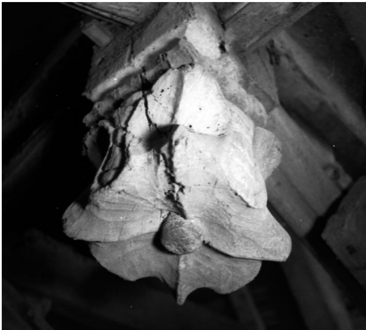
Charpente, détail de la clé 8.
