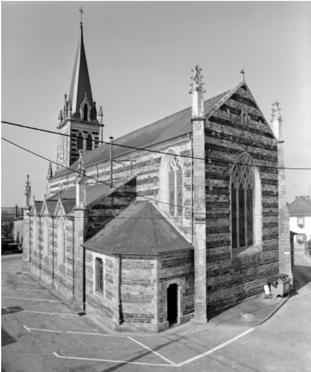
Vue générale nord-est
