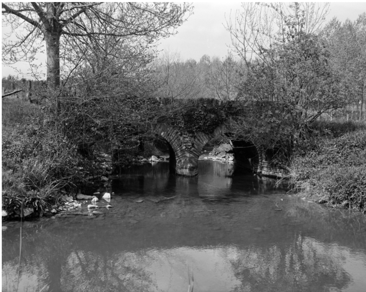
Ancien pont en contrebas du château, au nord : vue générale.
