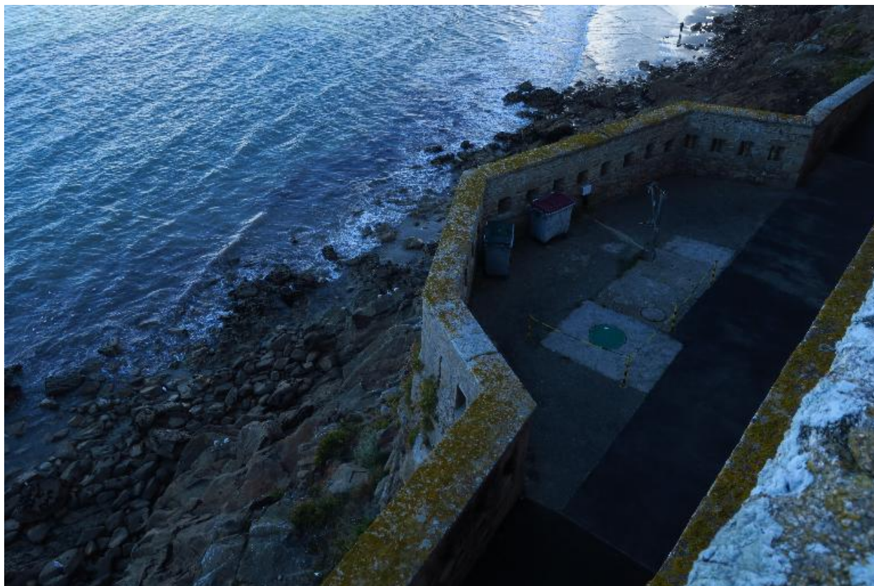
Saint-Pierre-Quiberon, fort de Penthievre, enceinte, parapet crénelé du réduit.
