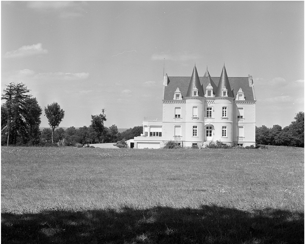
Château, vue générale sud.
