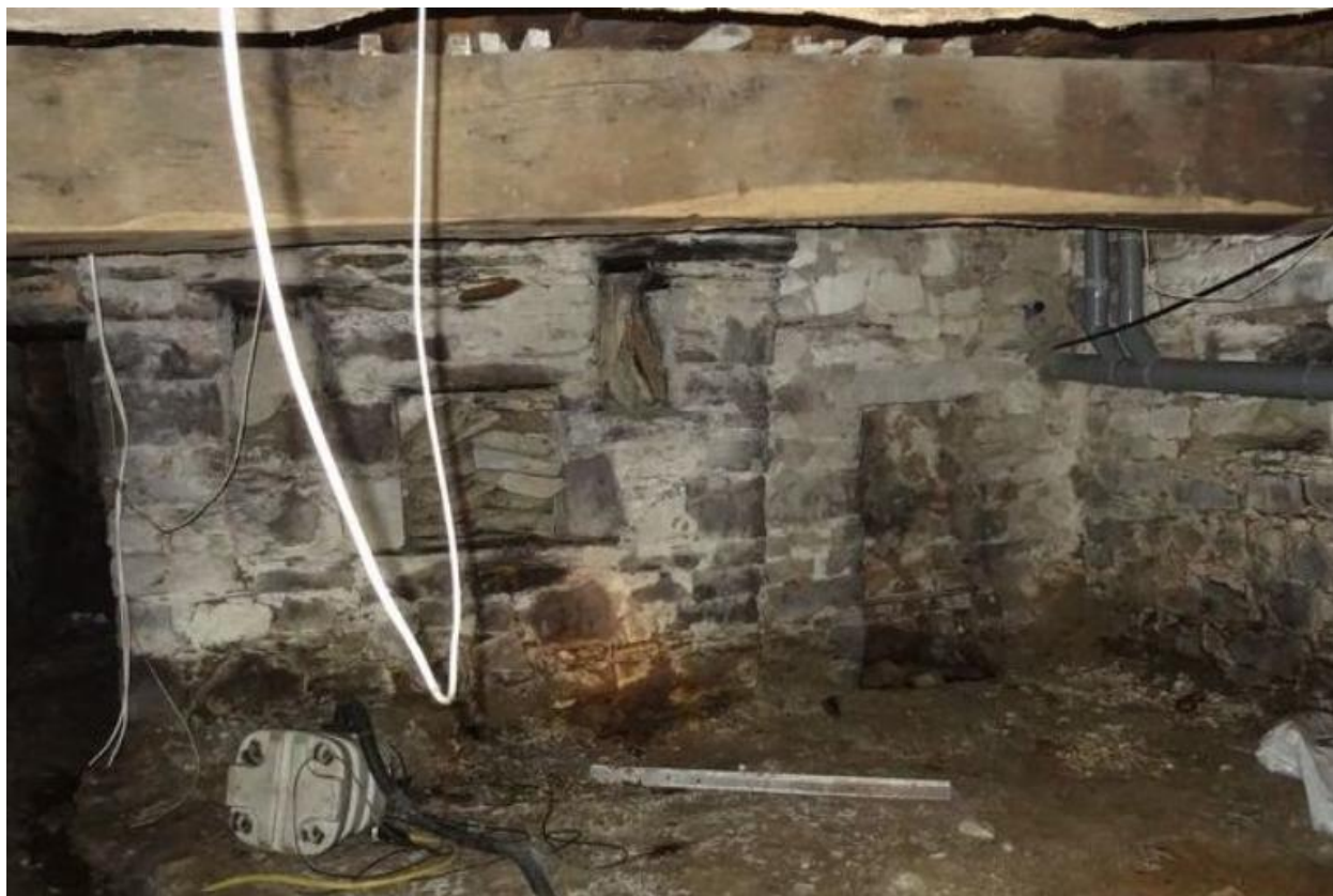
Côté sud du mur de refend, cave
