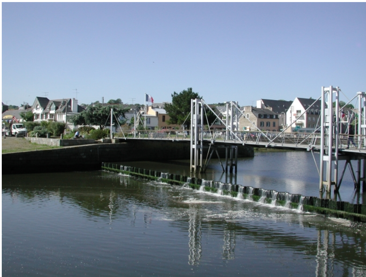
La passerelle au-dessus du bassin
