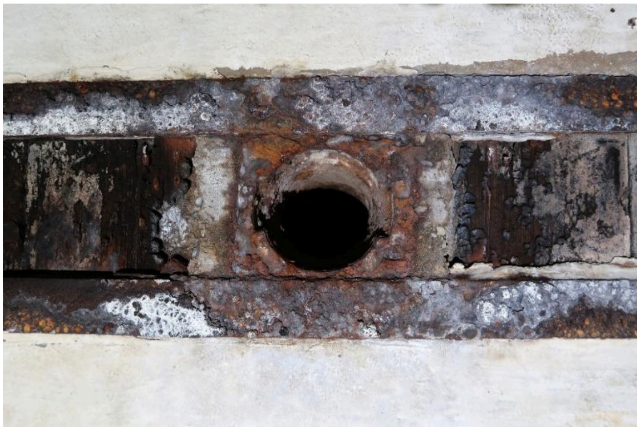
Vue intérieure : détail du plafond de la salle de garde ouest, puits pour un périscopes ?
