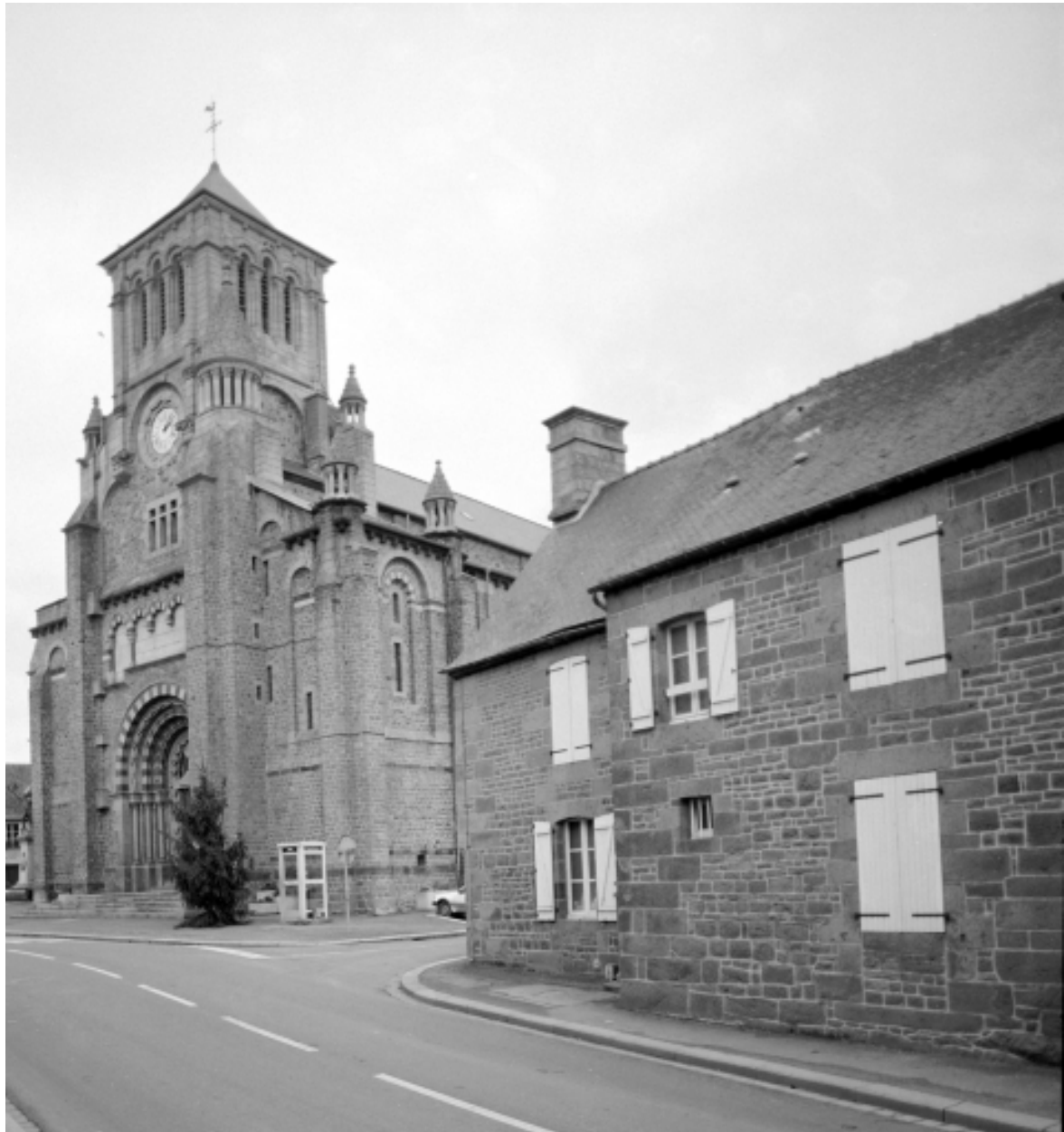
Elévation Nord-Ouest : vue générale
