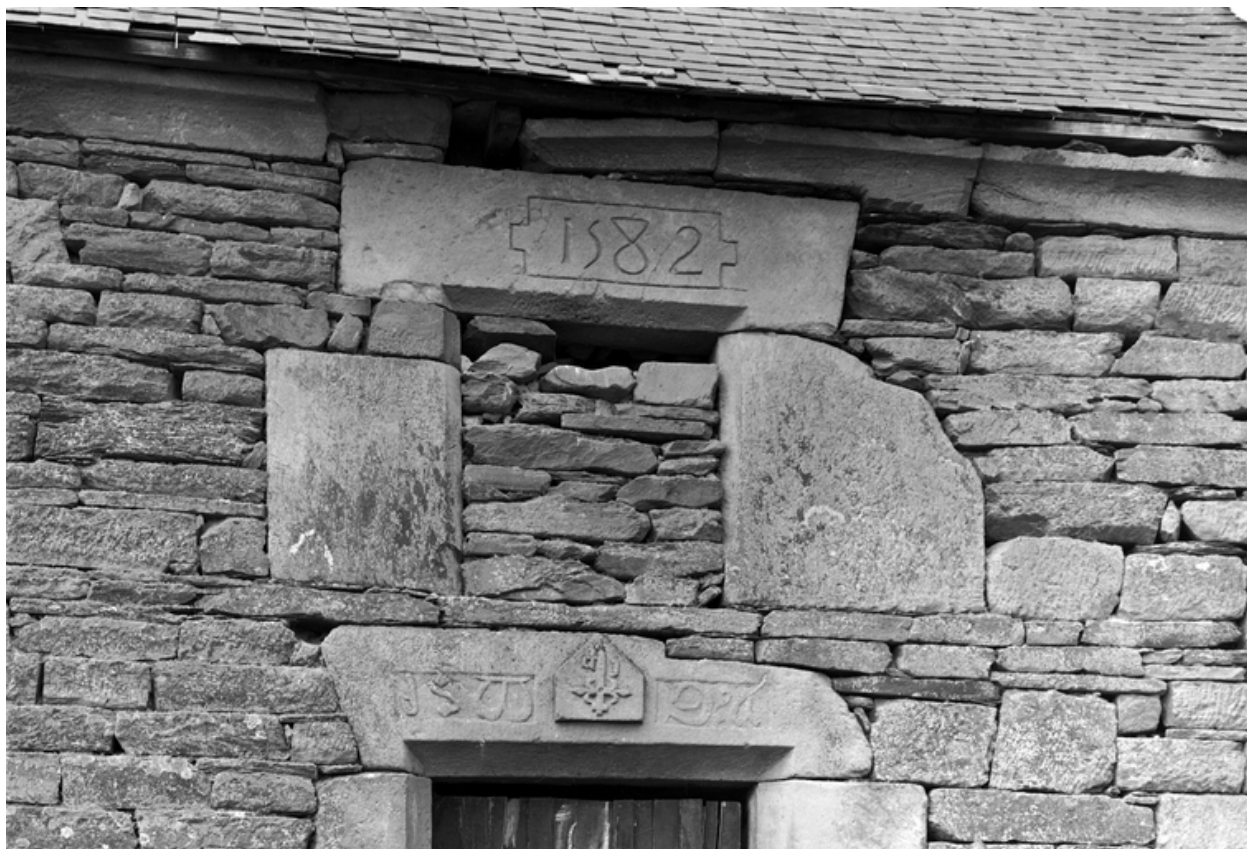
Linteau de porte à Kerbourou : façade
