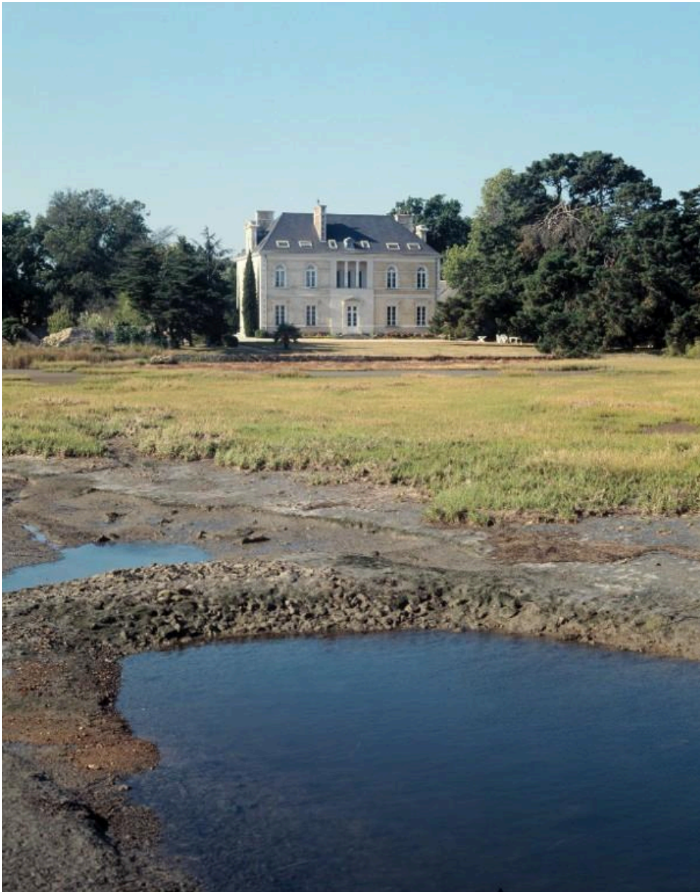
Vue générale nord.
