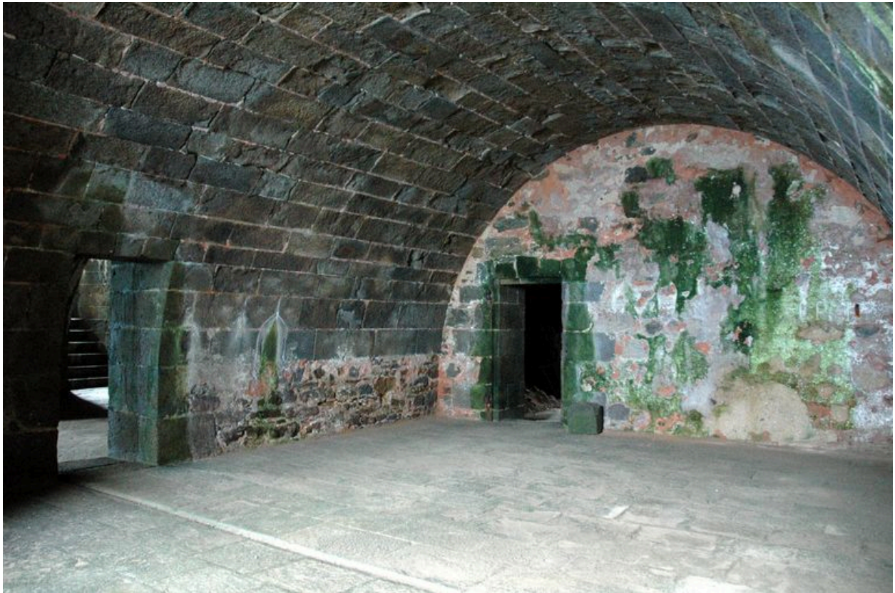
Vue du fort de la Conchée : chapelle dit souterrain doté d'une baie
