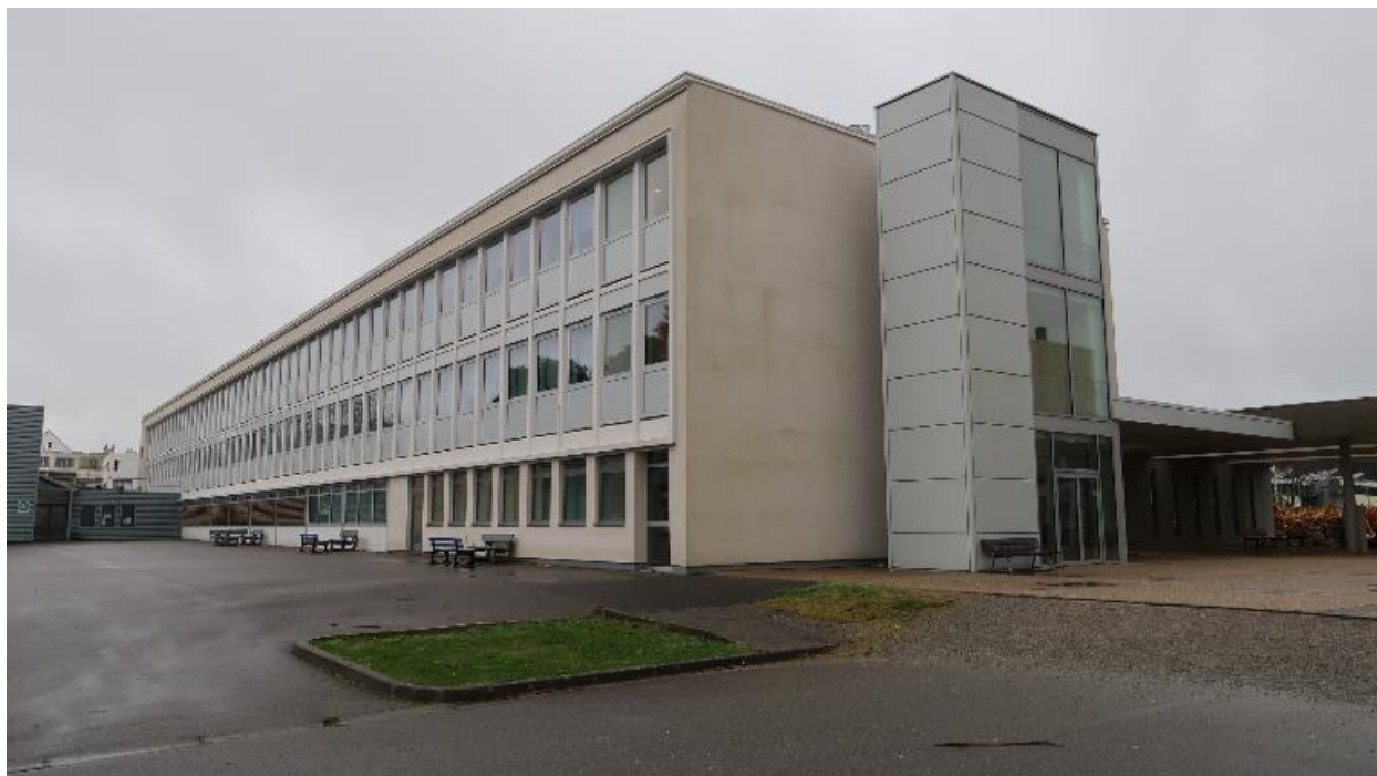
Vue d'ensemble du bâtiment C, façade sur cour. A gauche, la jonction avec le gymnase municipal.
