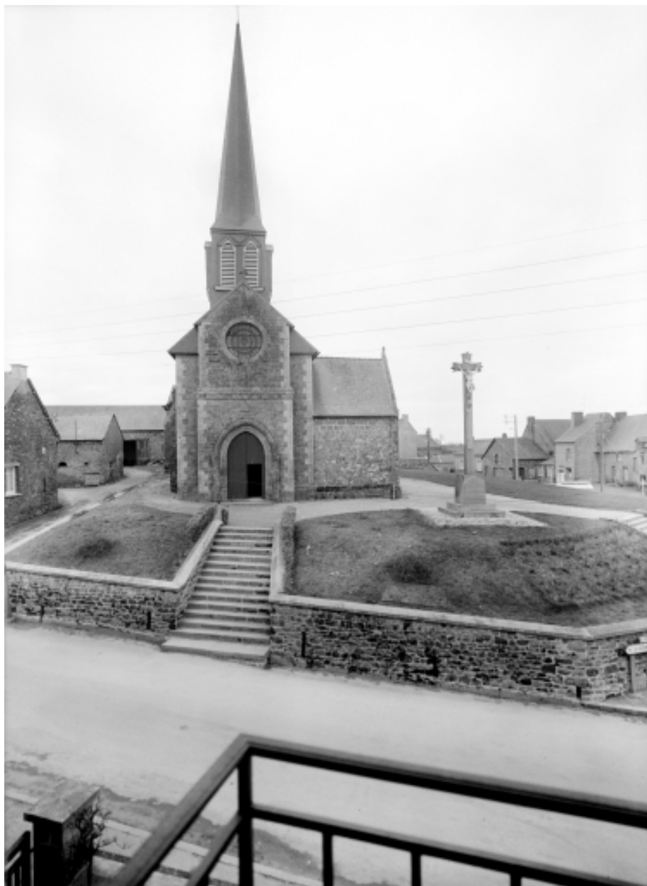
Elévation Ouest : vue générale
