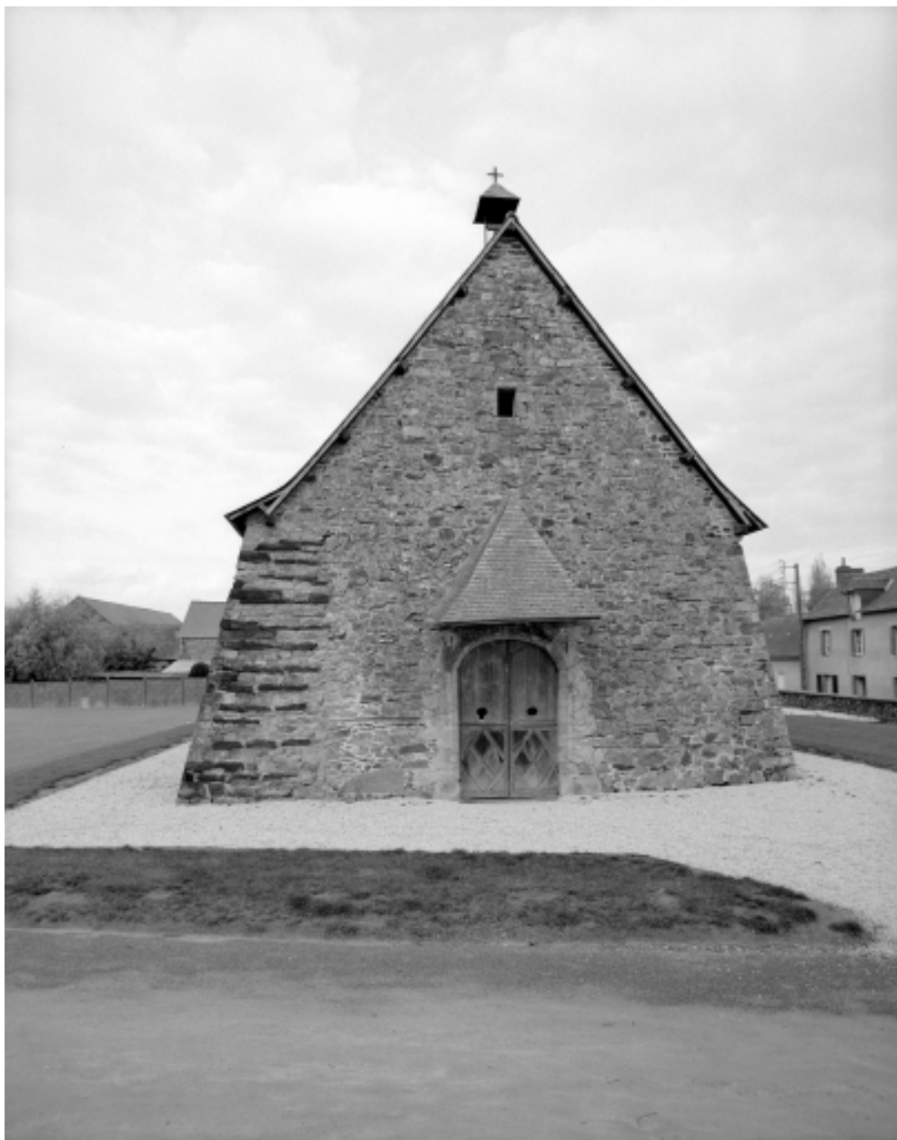
Elévation Ouest : vue générale
