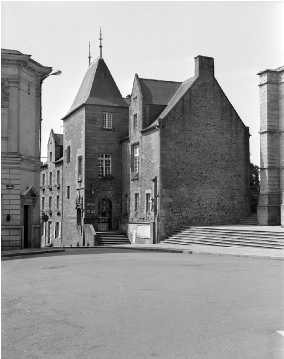
Vue générale nord-est.
