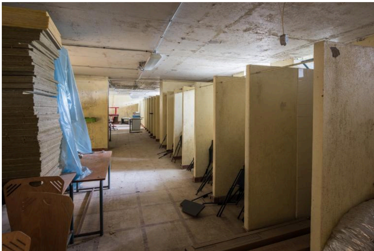
Rangée de douches installée dans le sous-sol lors de la restructuration de l'établissement après la Seconde Guerre mondiale.
