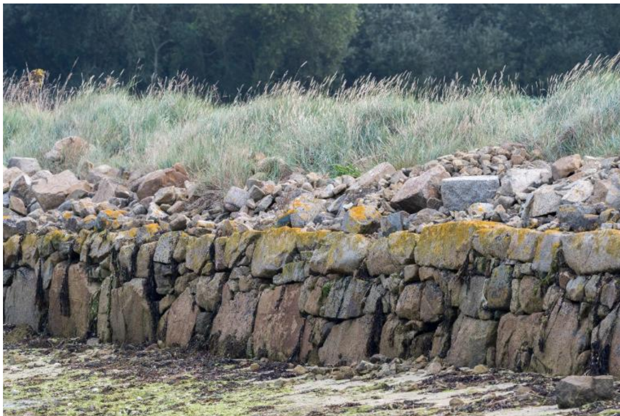
Mur de soutènement composé de gros blocs de granite, et couronné de pierres de champ, au fond de l'anse de Pelinec
