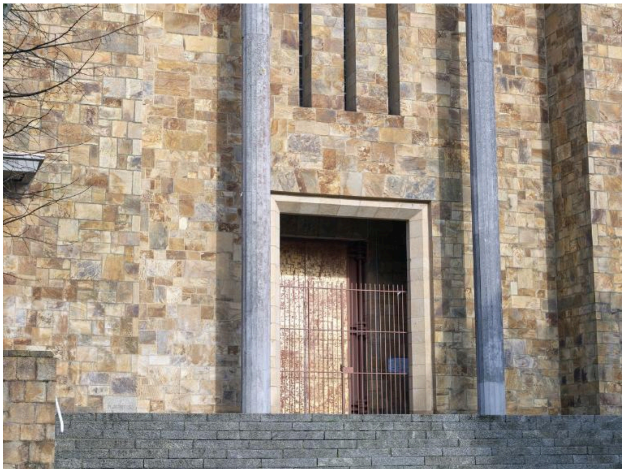
Eglise Saint-Louis, élévation nord
