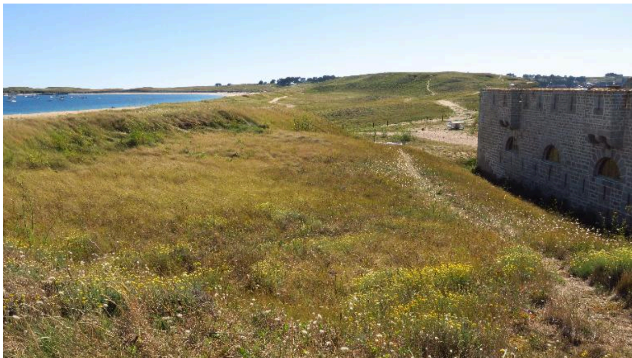
Île-d'Houat, batterie d'En Tal, terre-plein et parapet.
