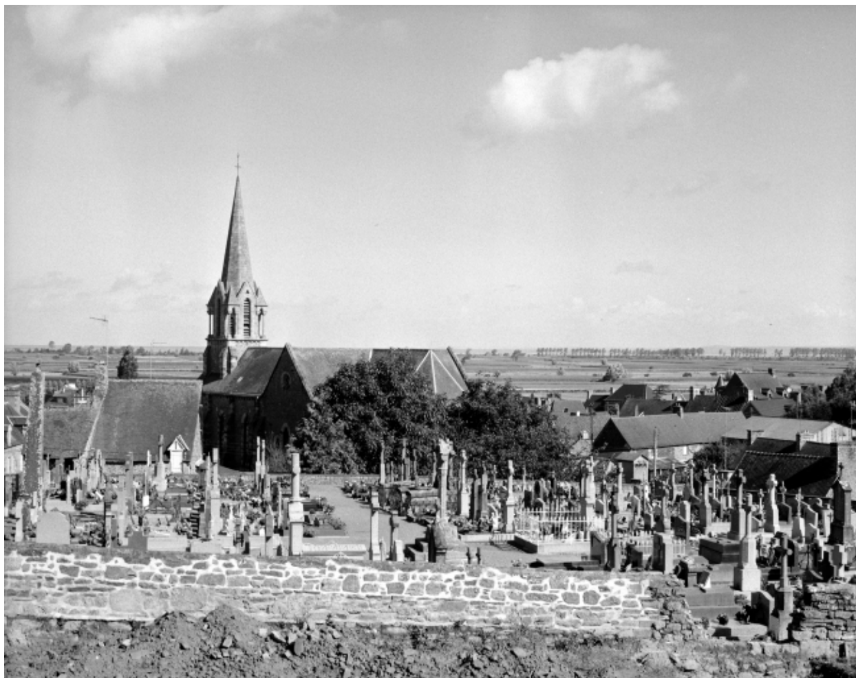
Elévation Sud-Ouest : vue générale
