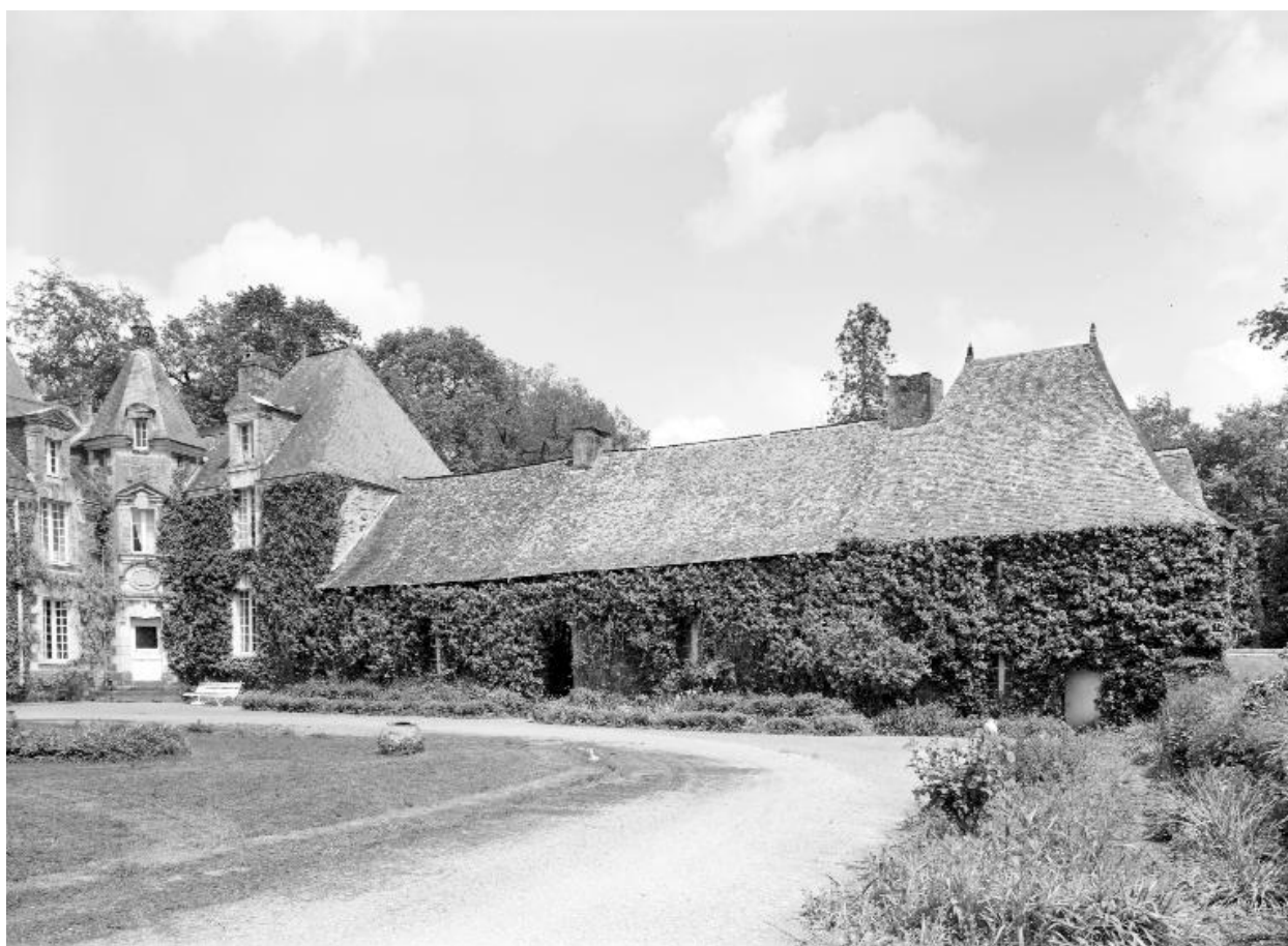
Château, logis et aile sud : élévation ouest (état en 1983)
