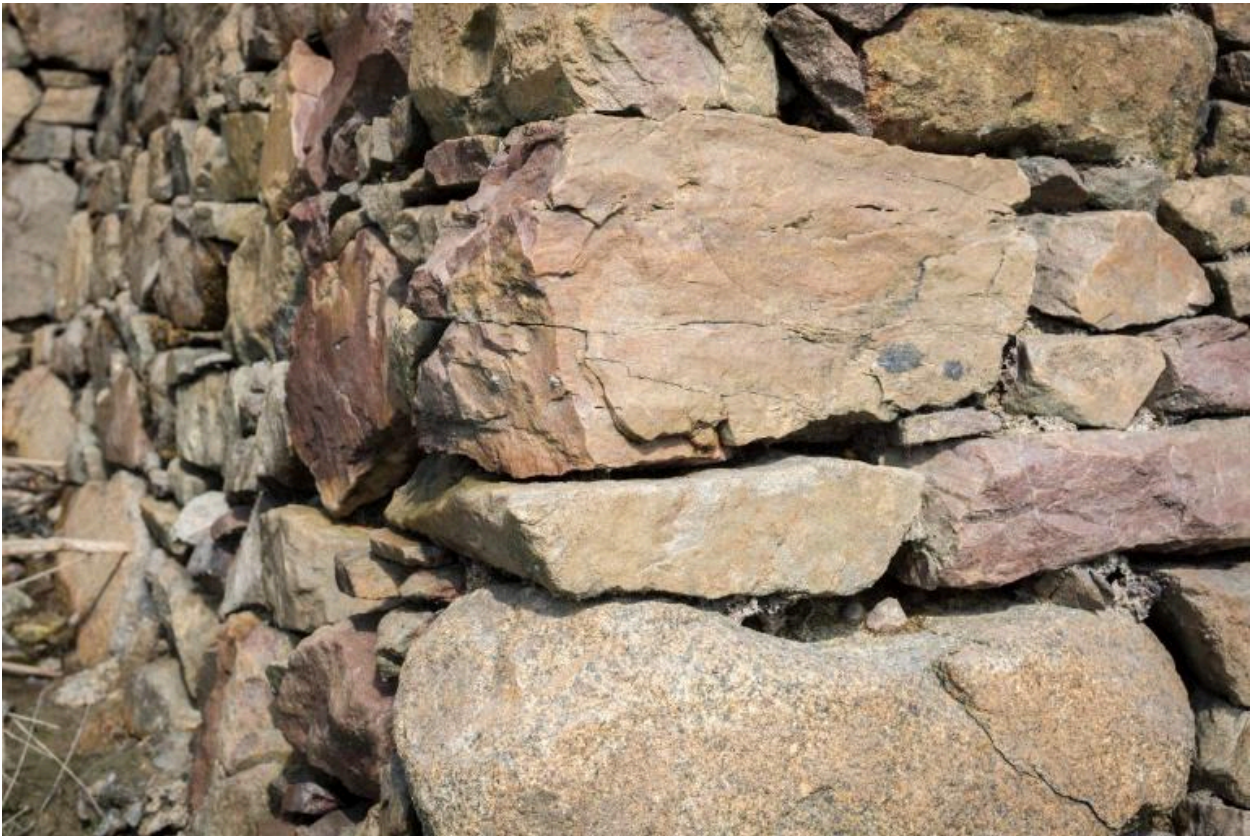
Vue de détail de deux parements en pierre sèche formant un angle au sud du four à chaux
