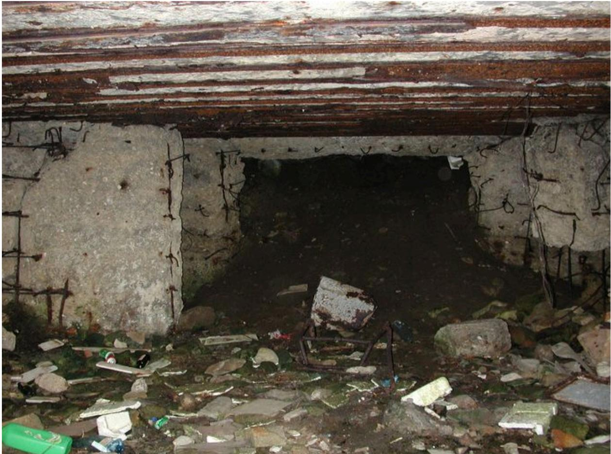
Vue de l'intérieur de la casemate de Beg Tanguy endommagée par le souffle d'une explosion durant le déminage
