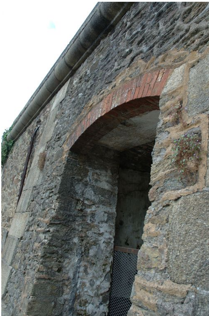
Vue des latrines collectives (contre-plongée) : porte gauche aménagée ultérieure (arc segmentaire en brique)
