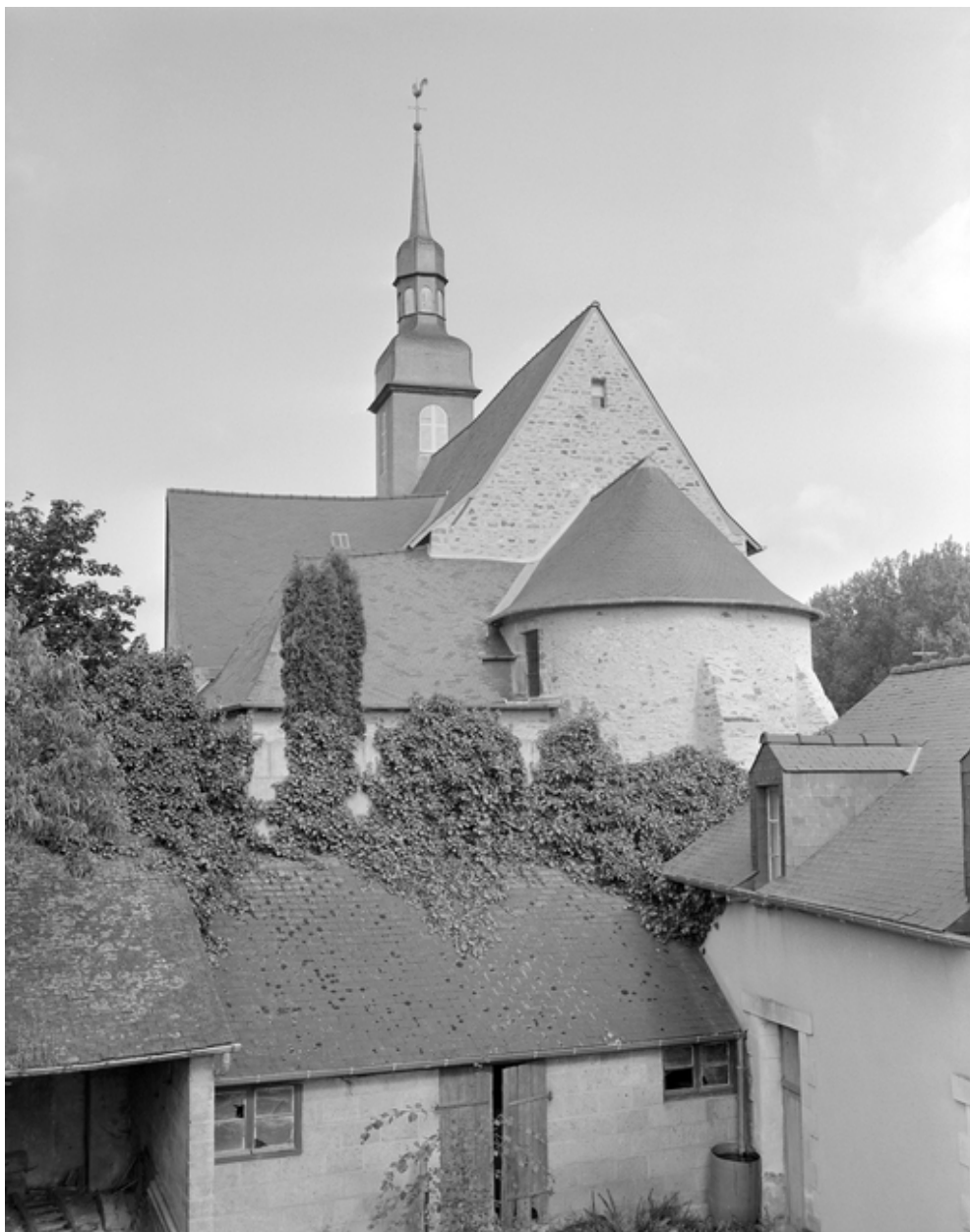
Elévation Sud-Est : vue générale
