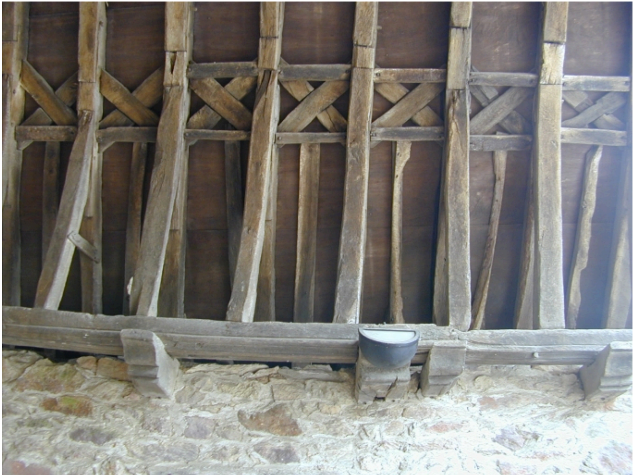
Détail de la charpente du porche
