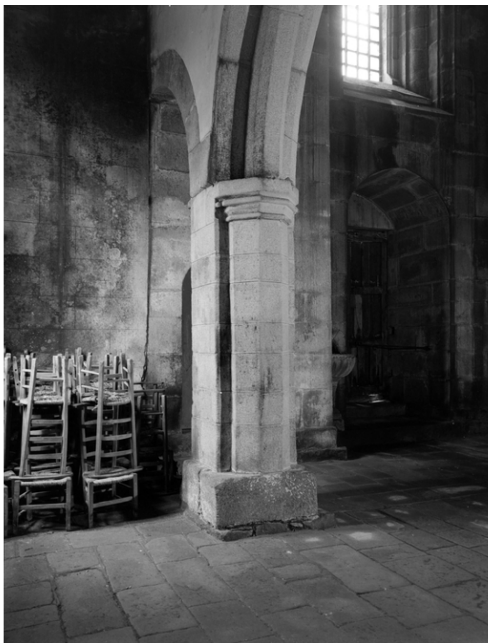
Nef : vue du pilier sud n°1
