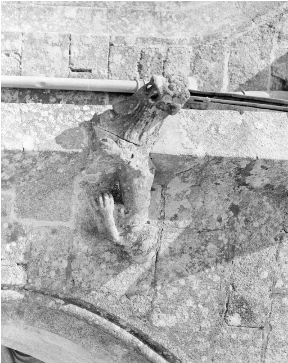
Quéménéven, église paroissiale Saint-Ouen : façade sud, le porche, détail crossette gauche, état en 1972
