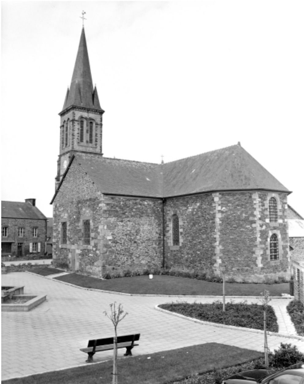
Elévation Sud-Est : vue générale
