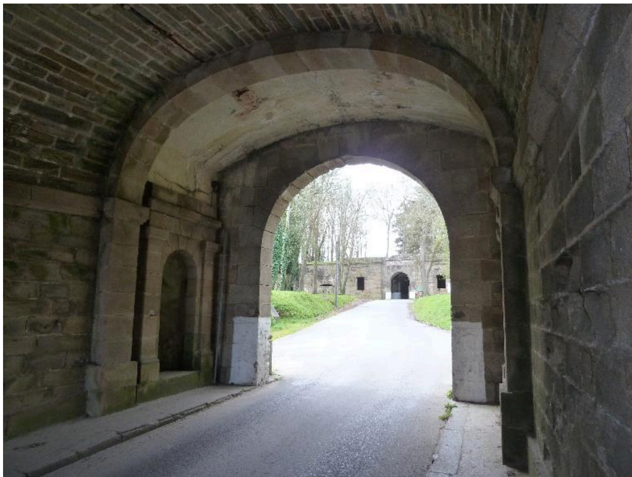
Le Palais, enceinte urbaine, porte Vauban, passage voûté côté campagne.
