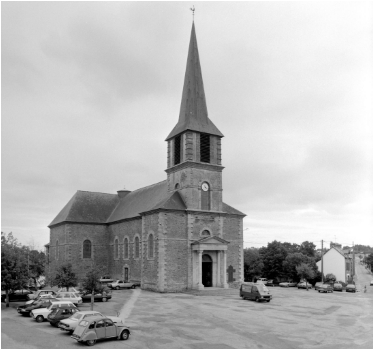
Elévation nord-ouest : vue générale
